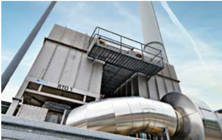
Lugtforbrændingsanlæg på Daka SecAnim i Randers
